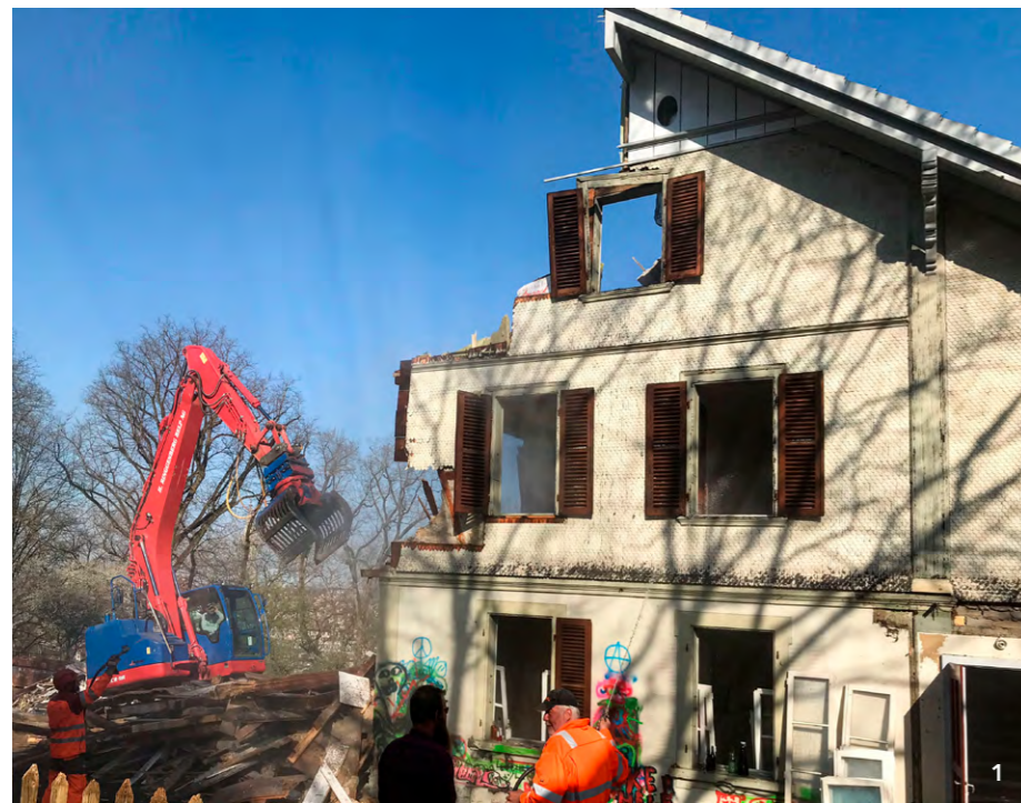
1 140 Jahre alt war das Haus, dessen umfassende Sanierung zu aufwändig und sehr kostspielig gewesen wäre. 2 Platz für viel mehr Leute: Im ökologischen Holzhaus wohnen nun insgesamt 12 Personen. 3 Blick ins Grüne hoch über dem Bärengaben. 4 Das Mehrgenerationenhaus mit Sonnenterrasse am Aarehang in Bern.
