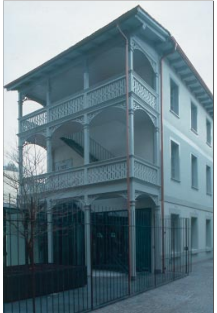
Laube Haus 45A nach Sanierung
