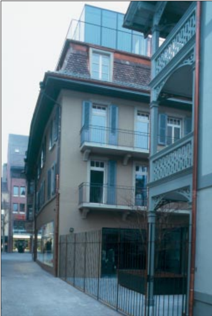
Seitengasse mit Zwischenhof nach Sanierung
