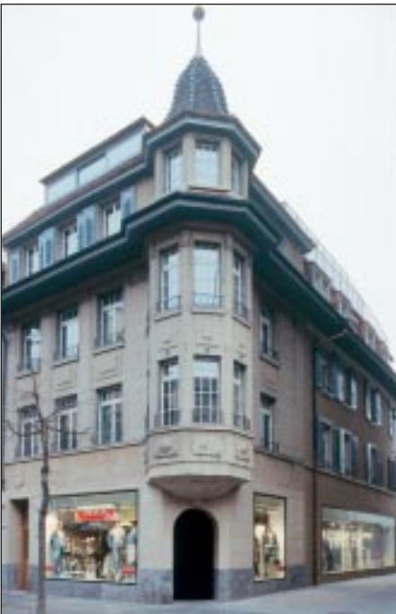
Bällizfassade nach Umbau
