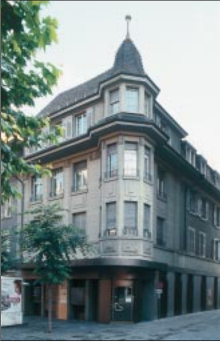
Bällizfassade vor Umbau
