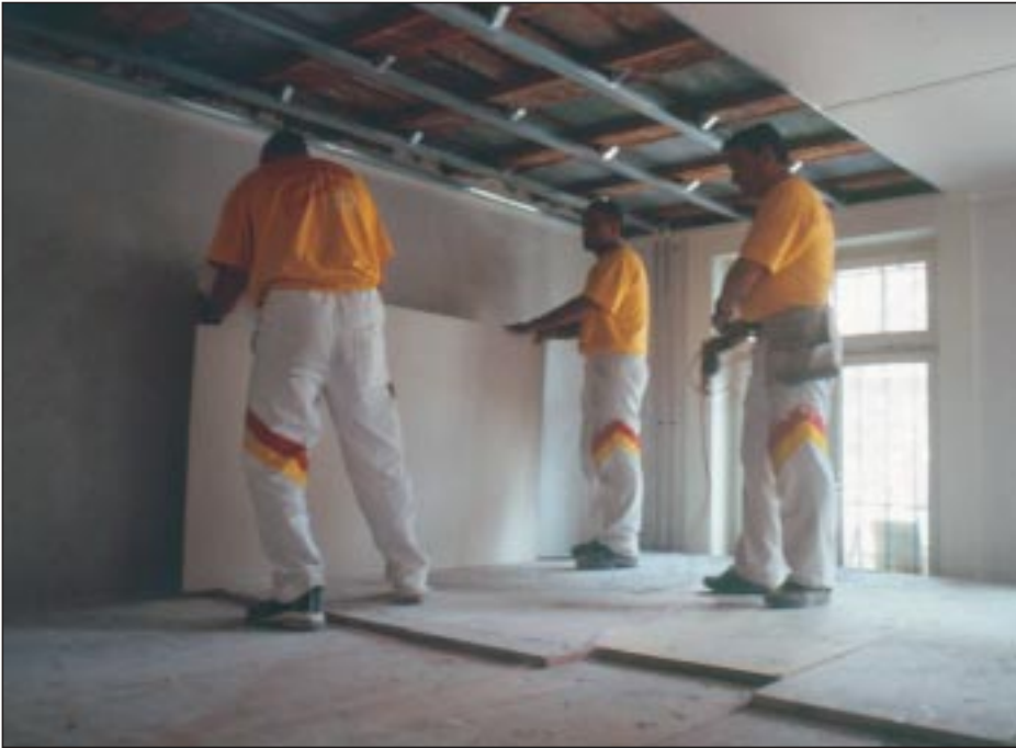
Gipser montieren eine Leichtbaudecke
