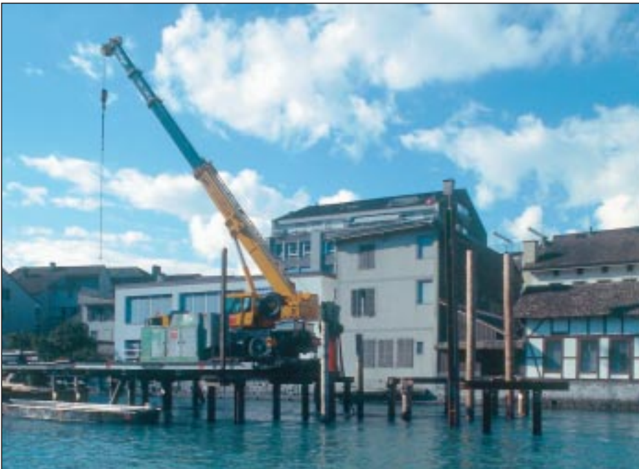
Erstellen der provisorischen Baubrücke
